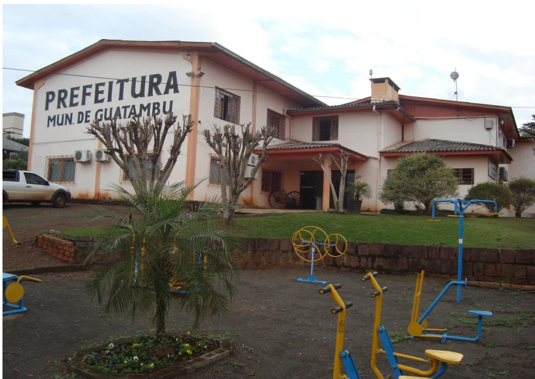
Centro Administrativo Municipal, GUATAMBU, SC.
